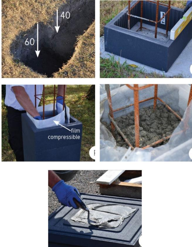
1. Creuser une fondation de 40 cm de profondeur et 10 cm plus large que l'élément à poser.
